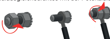
Abbildung 3: Anschluss des Geräts an ein elektrisches Potentialausgleichssystem.
